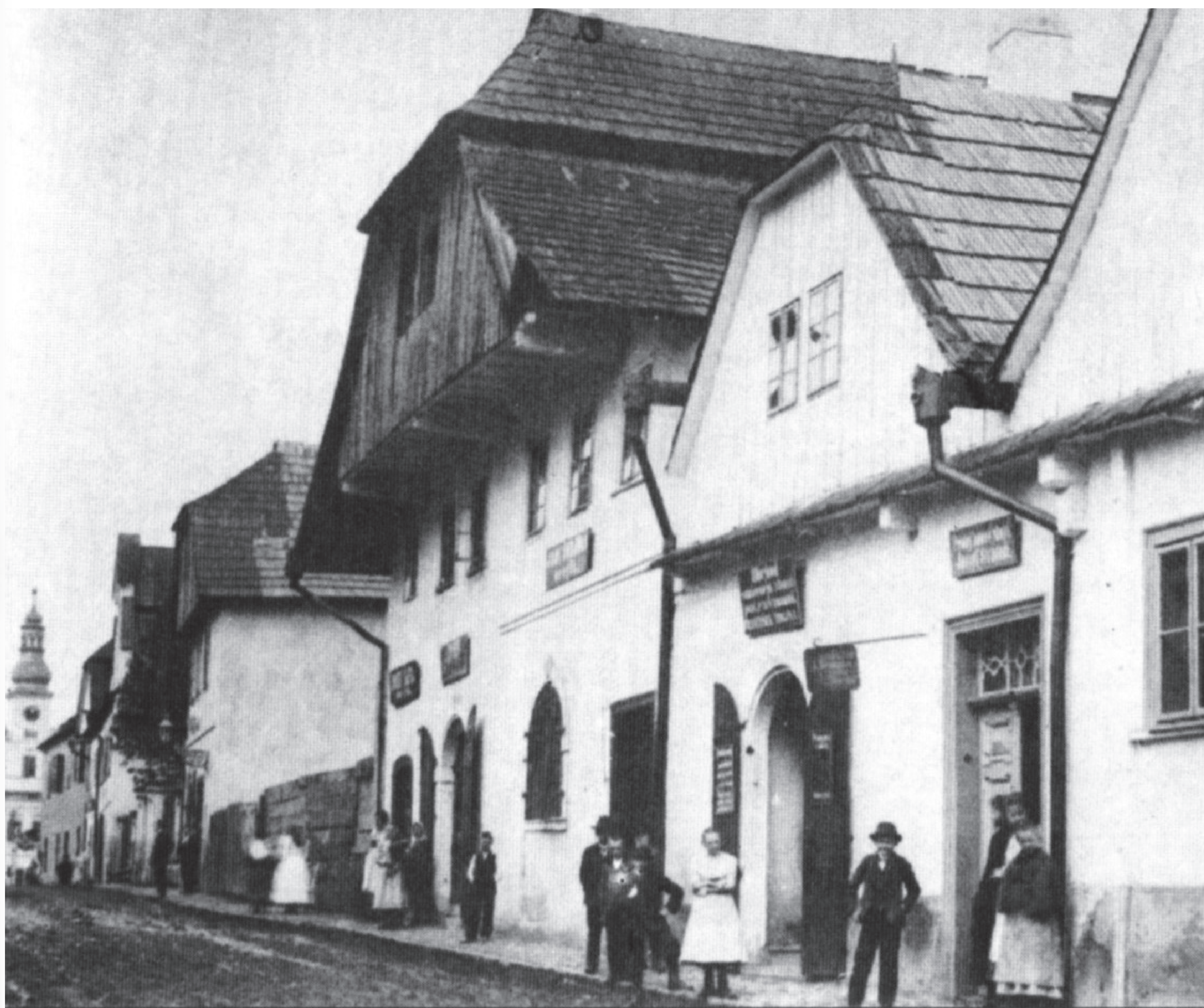
Židovská ulice (dnes Palackého) v Rychnově nad Kněžnou
